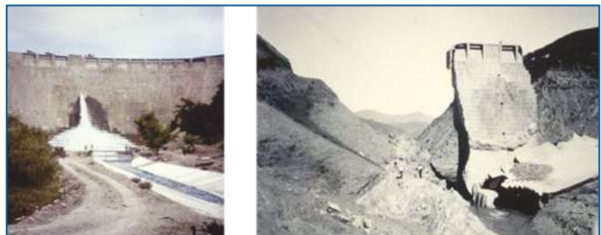
Rupture du barrage de San Fernando (USA), en 1971 Liquéfaction du remblai hydraulique au cours d'un tremblement de terre
